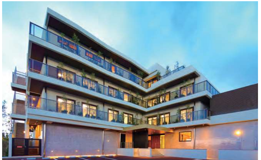
住宅型有料老人ホーム「ホスピタルメント甲東園」（兵庫県西宮市）。地上4階建て、59室。23年2月に外資系機関投資家へ売却
